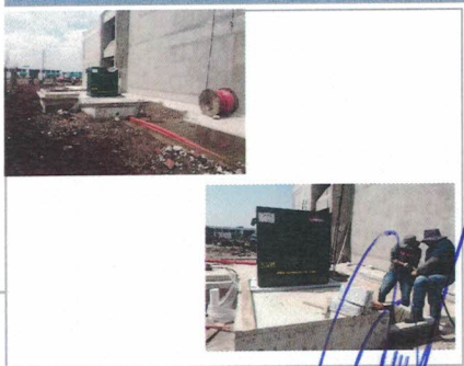
F3: ubicación de la subestación eléctrica
