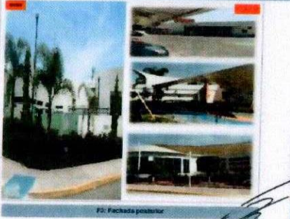
F3: Fachada posterior
