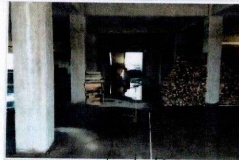
F5: Interior de la obra
