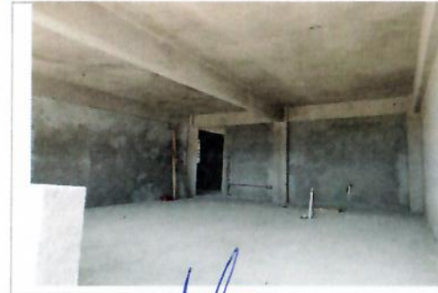
F5: Interior de aula para equipamiento
