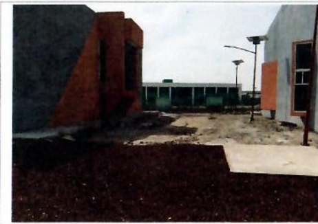
F4: Ubicación Subestación Eléctrica
