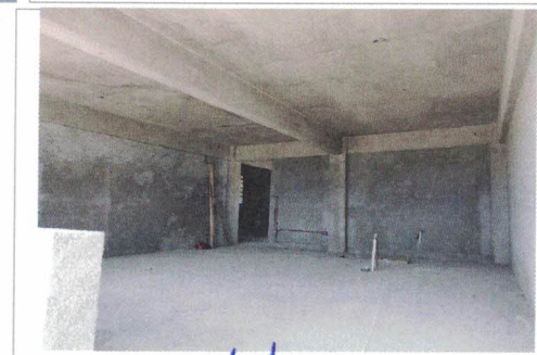
F5: Interior de sala para equipamiento
