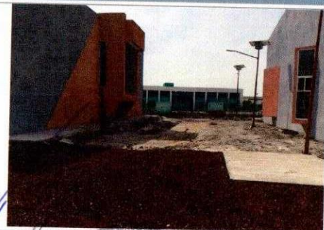
F4: Ubicación Subestación Eléctrica
