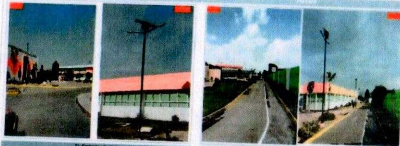
P1. Instalación de lámparas
