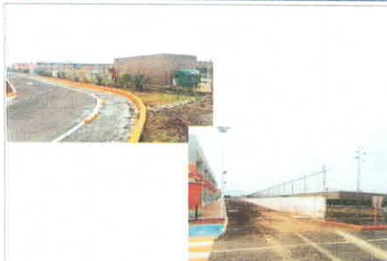
F4. Adecuación y mejora de la Banda Peatonal del Campus Universitario.
