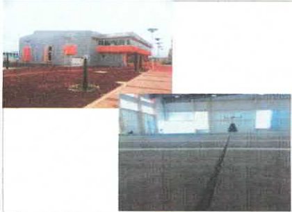
F1. Rehabilitación de Edificio de Gimnasio.
